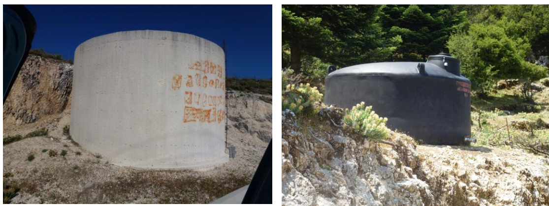
Εικόνα 3. Υδατοδεξαμενες στον Εθνικό Δρυμό τσιμεντένιες (αριστερά), πλαστικές (δεξιά)
