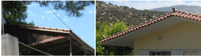
Αντιπαράθεση κεραμικών στεγνών. Αριστερά στέγη με ξύλινο υπόβαθρο, εύφλεκτη. Δεξιά, τσιμέντινη, δεν αναφλέγεται. Και στις δύο περιπτώσεις η βλάστηση ακουμπά στις στέγες, γεγονός που αυξάνει τον κίνδυνο από πυρκαγιά.
